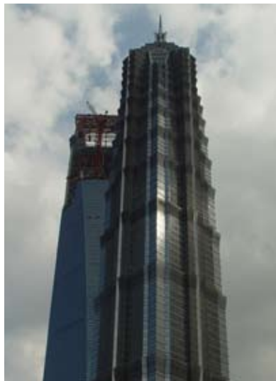
De hoogste ter wereld in aanbouw.
